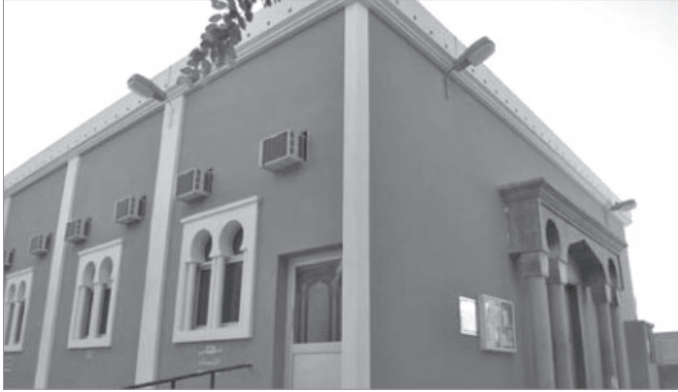
مسجد مؤمن البناء الأخير ٢٠٠٠م
